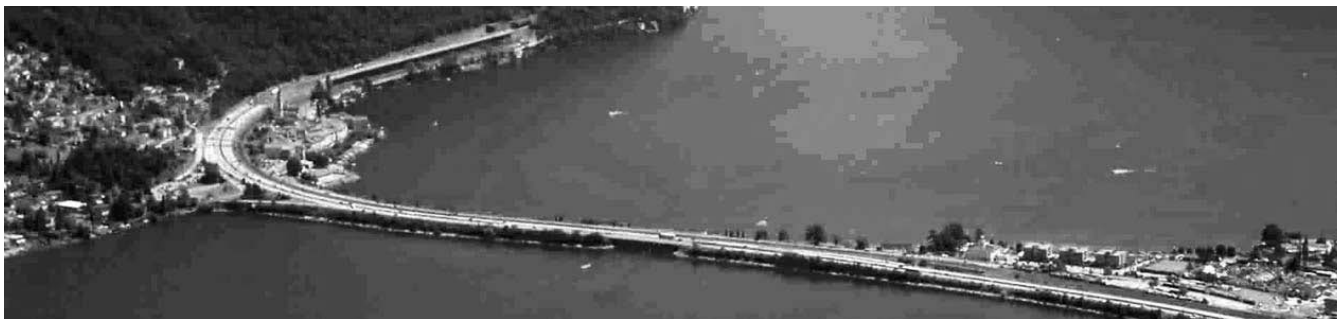
La realizzazione del progetto di risanamento fonico della A2 e delle FFS è imminente. Il cantiere verrà aperto nell'autunno 2008 e l'investimento è di 70 milioni di franchi
